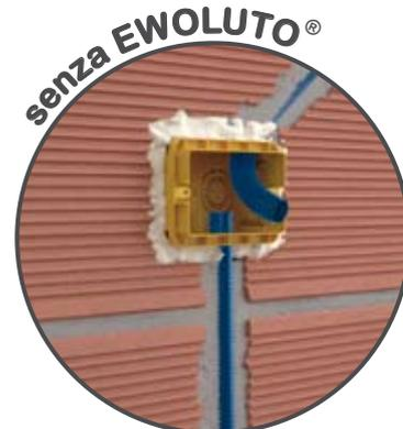
L'elettricista deve rompere il muro in prossimità della porta per far passare i cavi elettrici e allineare correttamente le scatole. In seguito, il muratore dovrà ripristinare il muro con l'intonaco.
